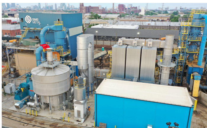
Nuevo sistema avanzado de captura y control de emisiones, ahora en funcionamiento en Sims Metal en Pilsen
